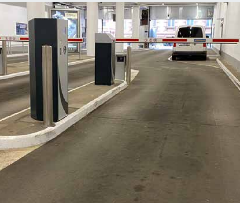
Ochrona instalacji wewnątrz budynków, np. kas automatycznych, szlabanów
